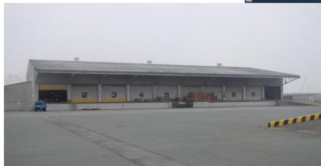
■大剣コンテナフレートステーション (面積: 1590.0㎡) Otsurugi container Freight Station
